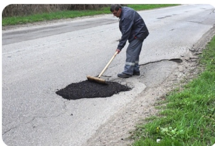
Разстилане и подравняване
